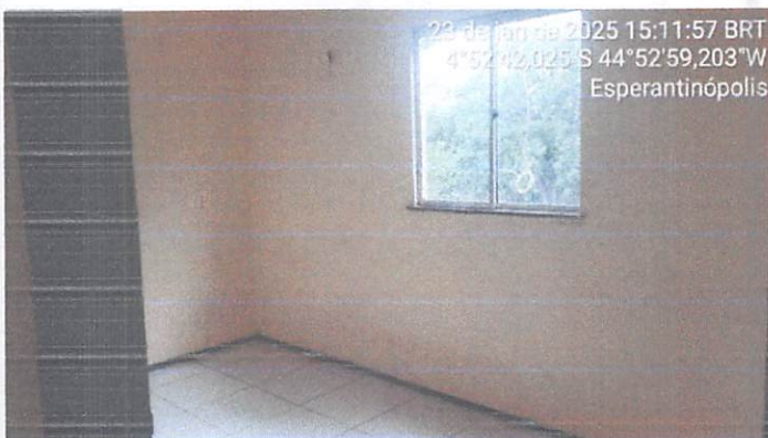
Foto 06 - Vista da sala 01
