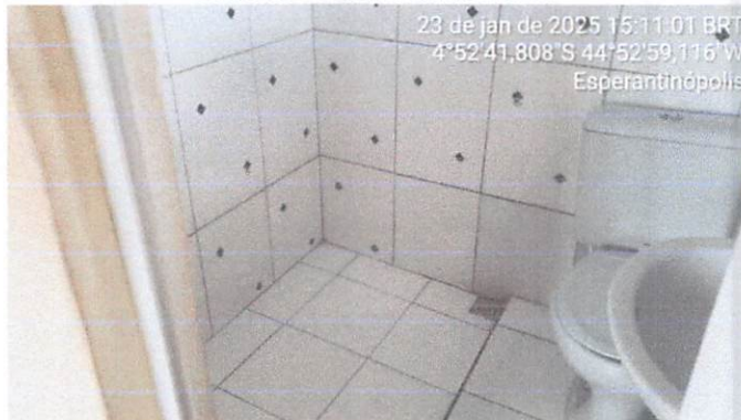
Foto 08 - Vista do banheiro 02
