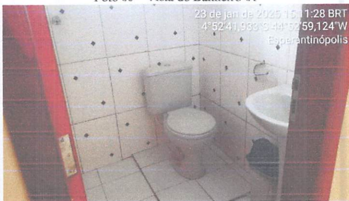
Foto 05 - Vista do Banheiro 01
