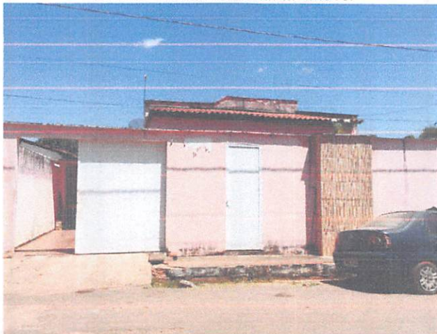
Foto 01 - Fachada frontal do imóvel
