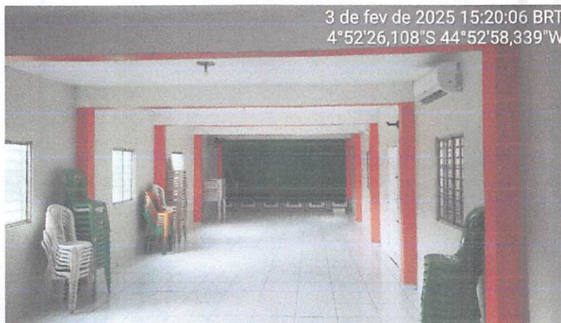
Foto 03 - Vista da sala 02
