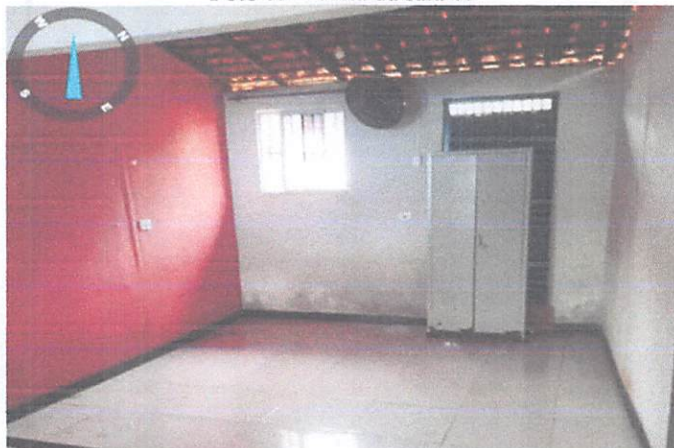
Foto 05 - Vista da sala 05
