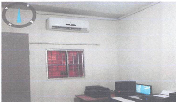
Foto 06 - Vista do escritório
