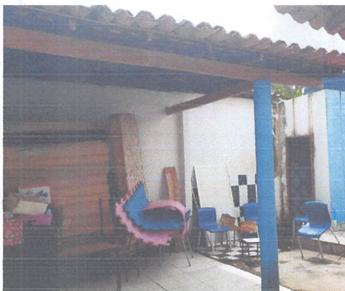
Foto 10 - Vista da área de apoio
