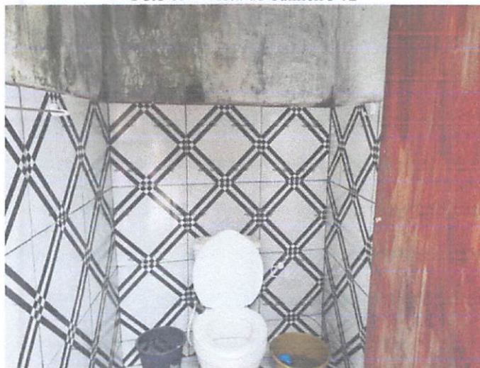
Foto 09 - Vista do banheiro 02
