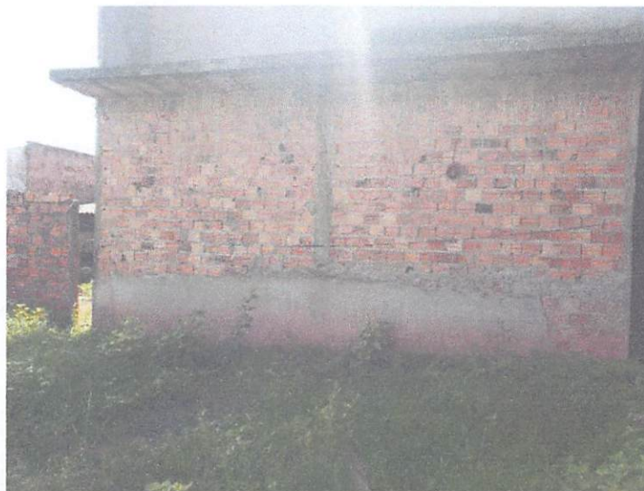
Foto 08 - Vista do fundo do imóvel
