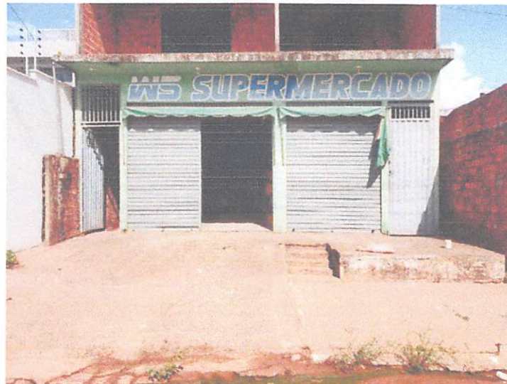
Foto 02 – Outra vista da Fachada frontal do imóvel
