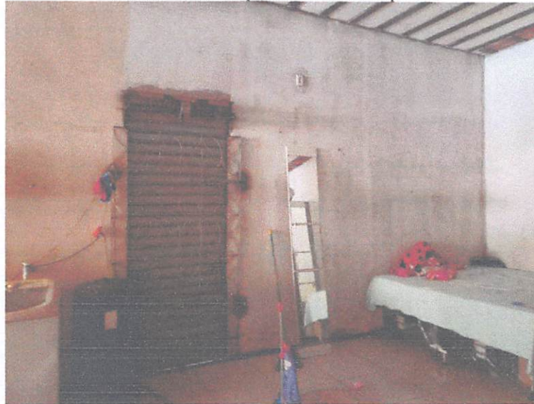
Foto 05 - Vista do portão lateral do depósito.
