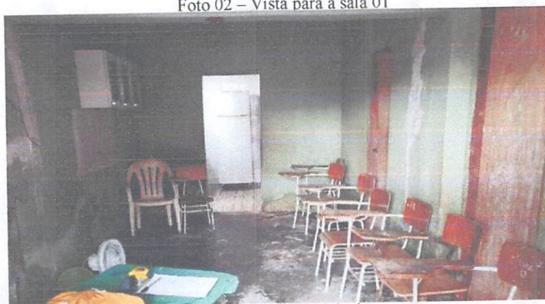
Foto 02 - Vista para a sala 01
