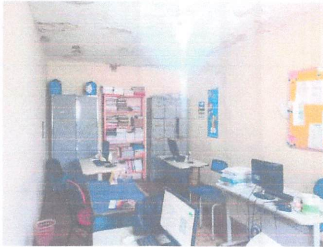
Foto 03 - Vista da sala 01
