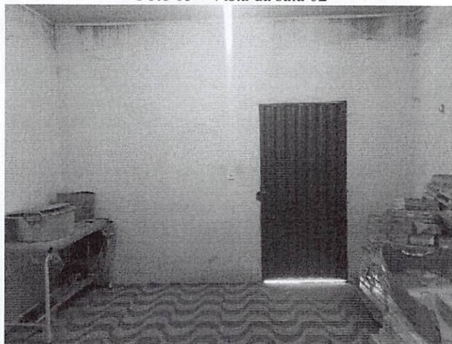
Foto 05 - Vista da sala 02
