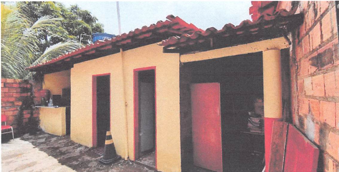
Foto 5: Área descoberta, depósitos e copa.
