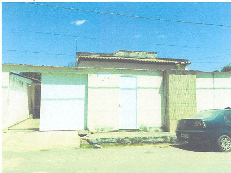
Foto 01: Fachada da edificação.
