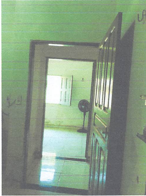
Foto 05: Vista do Quarto 1.
