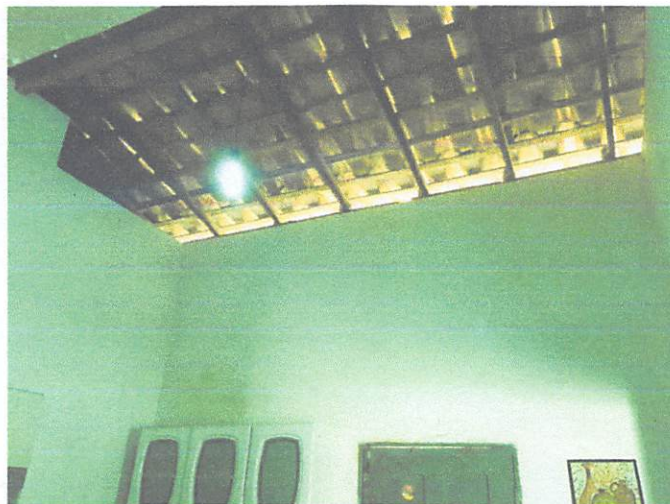
Foto 08: Cobertura na cozinha (telhado cerâmico).
