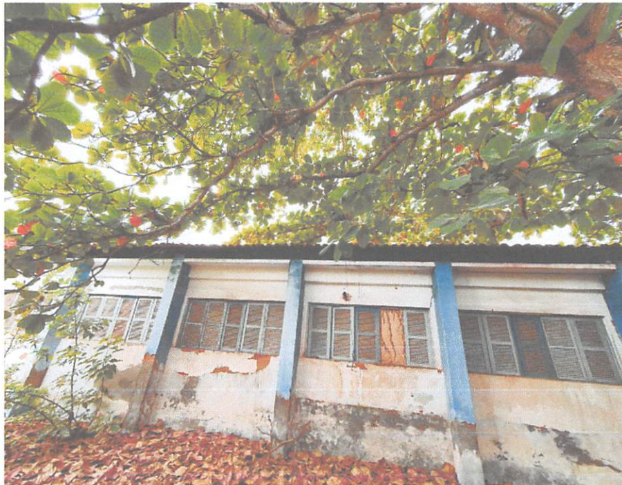
Foto 06: Um pé de amêndoa ( Terminalia Catappa L. ) exercendo influência no telhado do prédio público ao lado.
