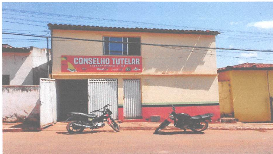
Foto 01: Fachada do imóvel onde está locado o conselho tutelar.
