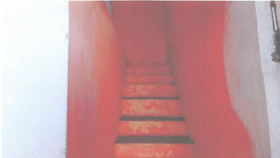
Foto 09: Escada de acesso ao piso superior.
