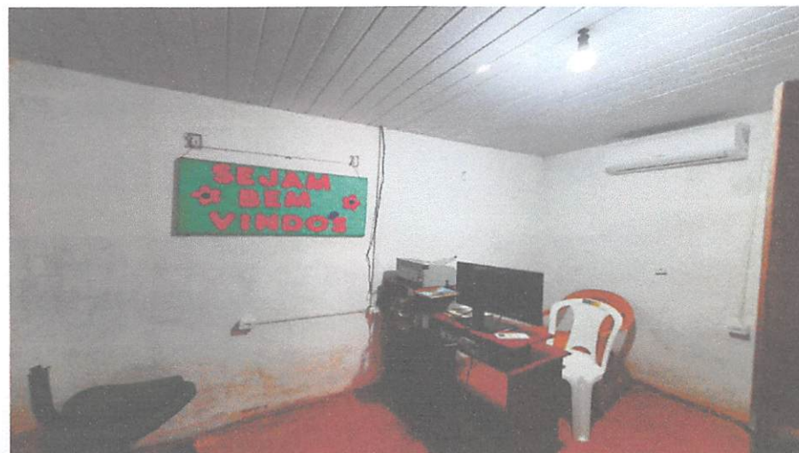
Foto 07: sala de atendimento 02
