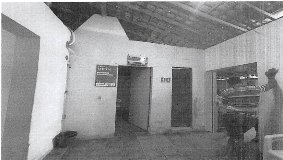
Foto 07: Área de circulação e acesso a sala de atendimento 04, gabinete, banheiro e cozinha.
