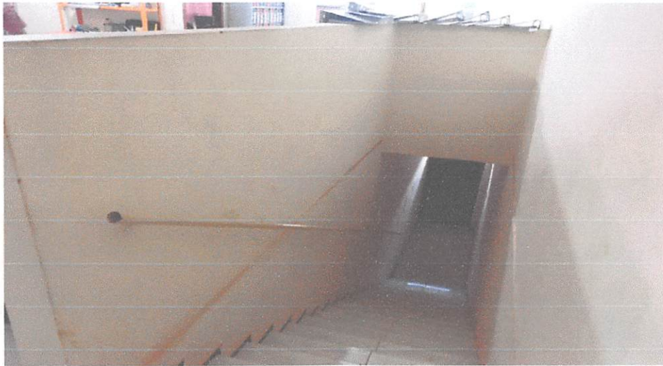
Foto 02: Escada de acesso à CPL.
