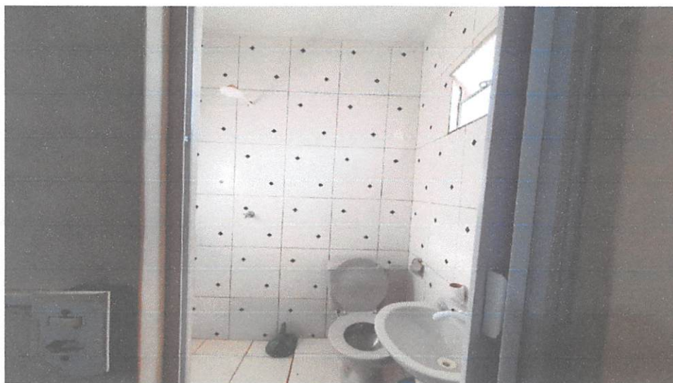
Foto 12: Banheiro 02 presente na sala 02.
